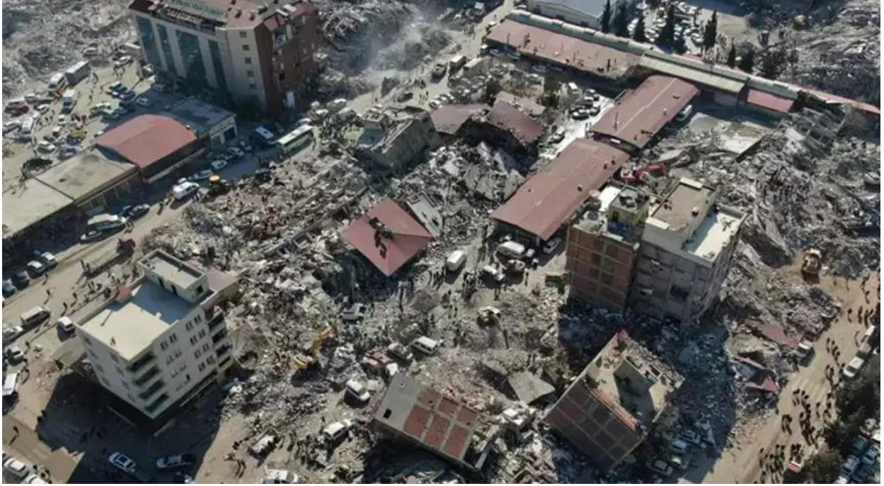
Şekil 2. Depremde hasar gören betonarme binalar
