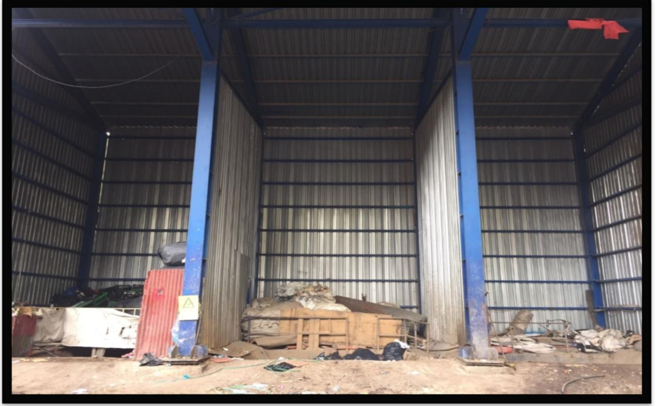
Şekil 2. Katı atık depo sahası
