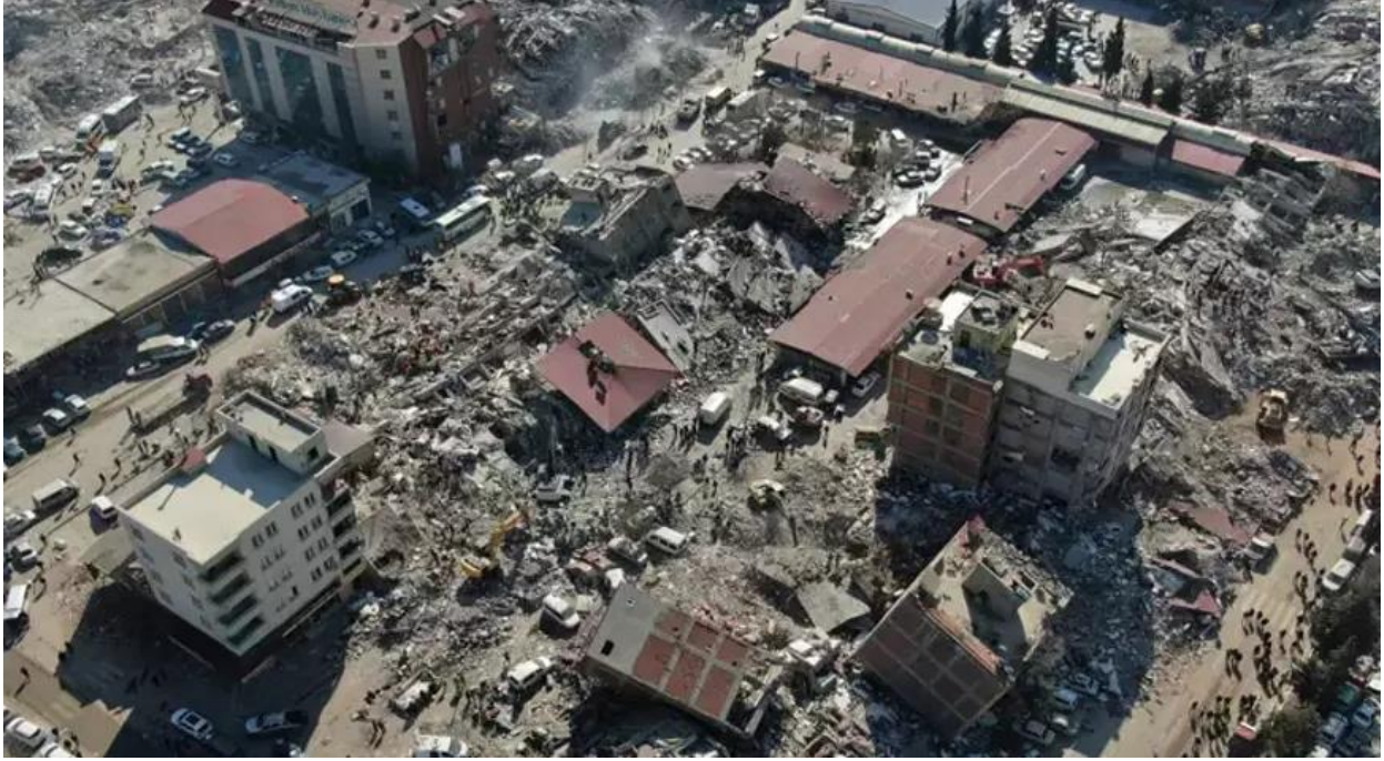
Şekil 2. Depremde hasar gören betonarme binalar
