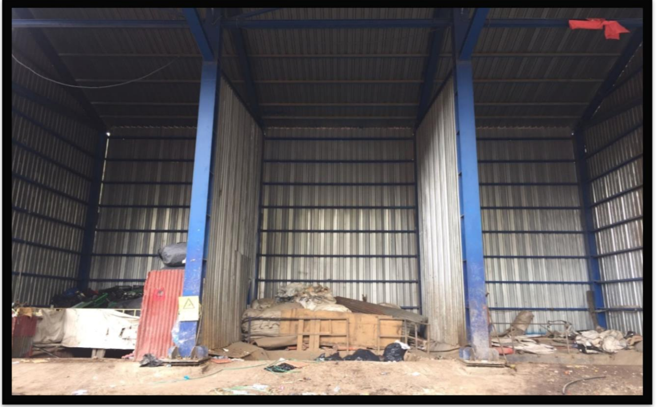
Şekil 2. Katı atık depo sahası
